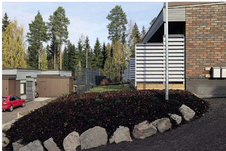
Tuulimyllyntie 23:n rivitalot sijaitsevat jyrkässä rinteessä. Ylempien talojen sisäpiha on pengerretty kivillä.
